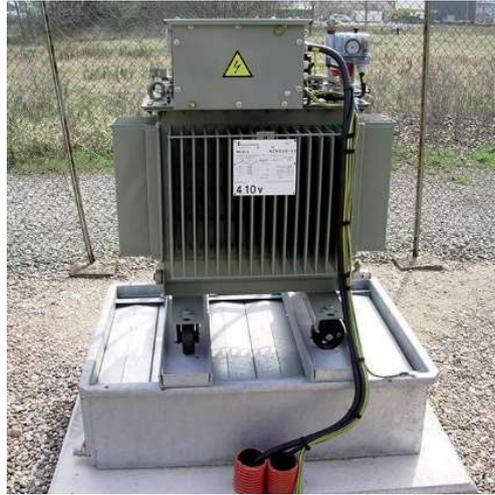
Figure 3 - Exemple de transformateur à huile et son bac de rétention (source : directindustry.fr)
